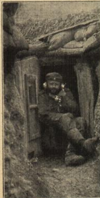
Telephonzelle im bombensicheren Unterstand.
