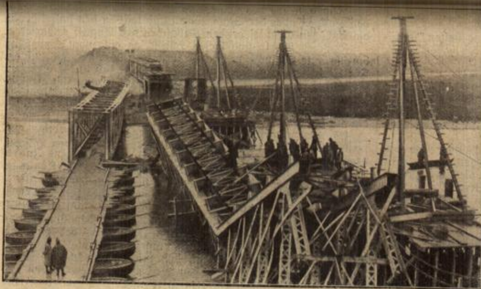
Die gesprengte Eisenbahnbrücke der Linie Kalisch—Warschau.
