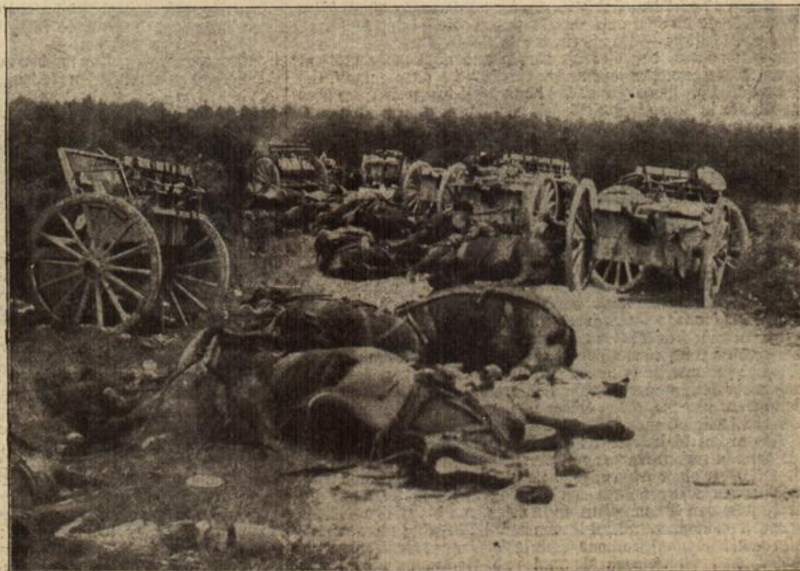
Schreden des Krieges: Zusammengeschossene französische Batterie. Phot. Schlesich-Ströblein, Frankfurt a. M.
