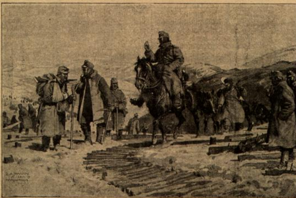
Herstellung von Anzüppeldämmen durch österreichisch-ungarische Arbeitsabteilungen.
