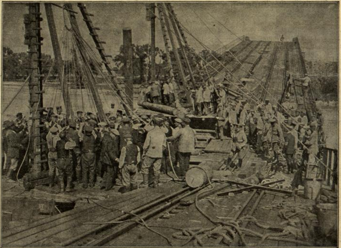
Deutsche Pioniere bei der Zustandsetzung der von den Russen gesprengten Weichselbrücken in Warschau. (Mit Text.)
