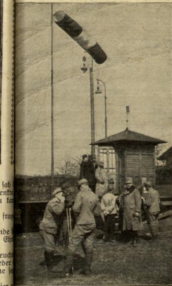
Ein losgelassener kleiner Ballon wird beobachtet und danach Windstärke und Richtung den Fliegeroffizieren der Luftschiffer- abteilung mitgeteilt.
