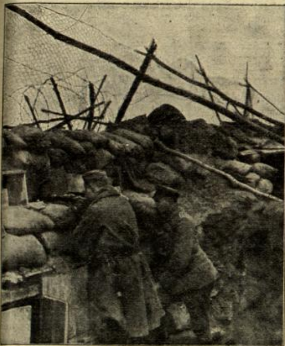
Sicherung der Schützengräben durch Drahtneze vor Handgranaten.
