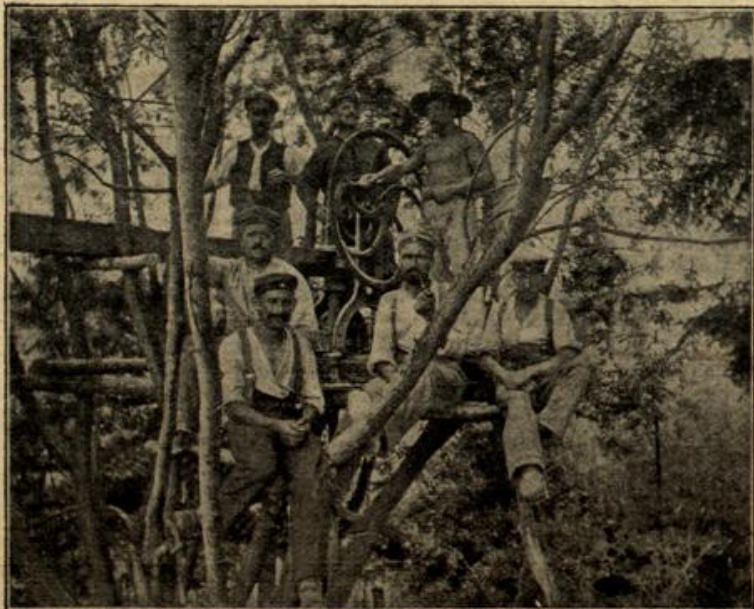
Pumpvorrichtung zum Entwässern und Trodenhalten von Schützengraben.
