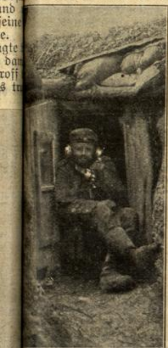
Stützpunkt im bombensicheren Unterstand.
