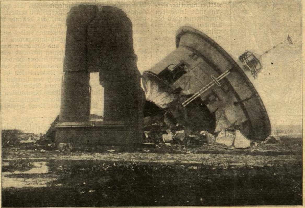
Der von den Russen gesprengte Bahnhof-Wasserturm in Remel. Phot. E. Vennighoven.
