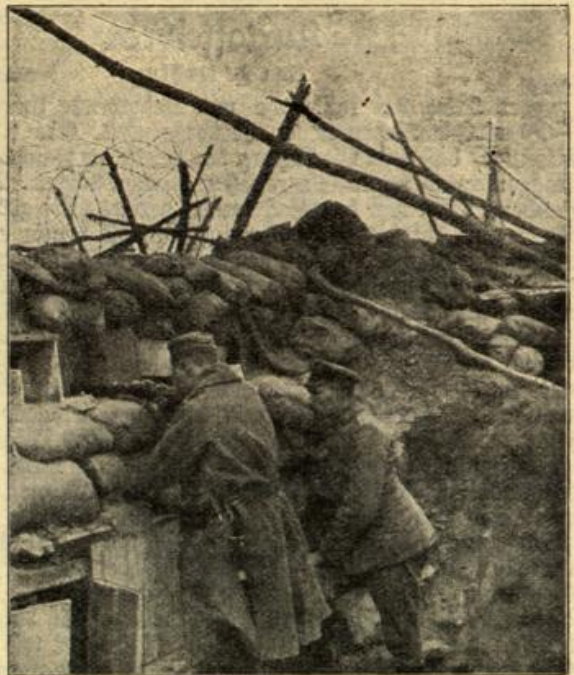
Sicherung der Schützengräben durch Drahtnetz vor Handgranaten.
