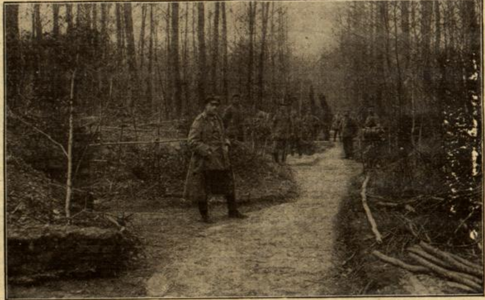
Strasse einer Kolonie der Erdwohnungen im Argonnenwald. (Mit Text.)
