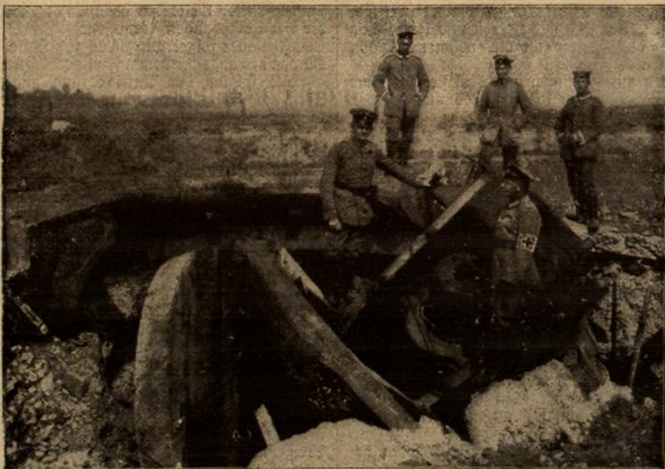
Zerschossener Panzerturm des Forts Louvain bei Lüttich. (Mit Text.)
