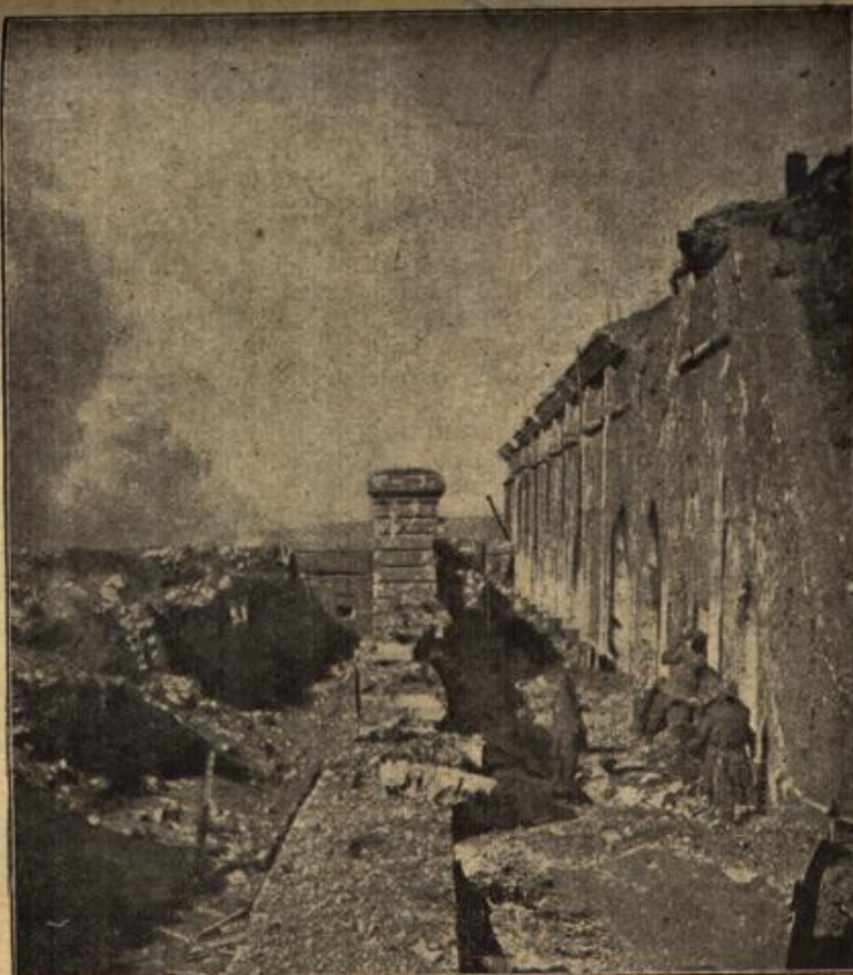
Die zerstörte Zitabelle und der Graben des Forts Baug.
