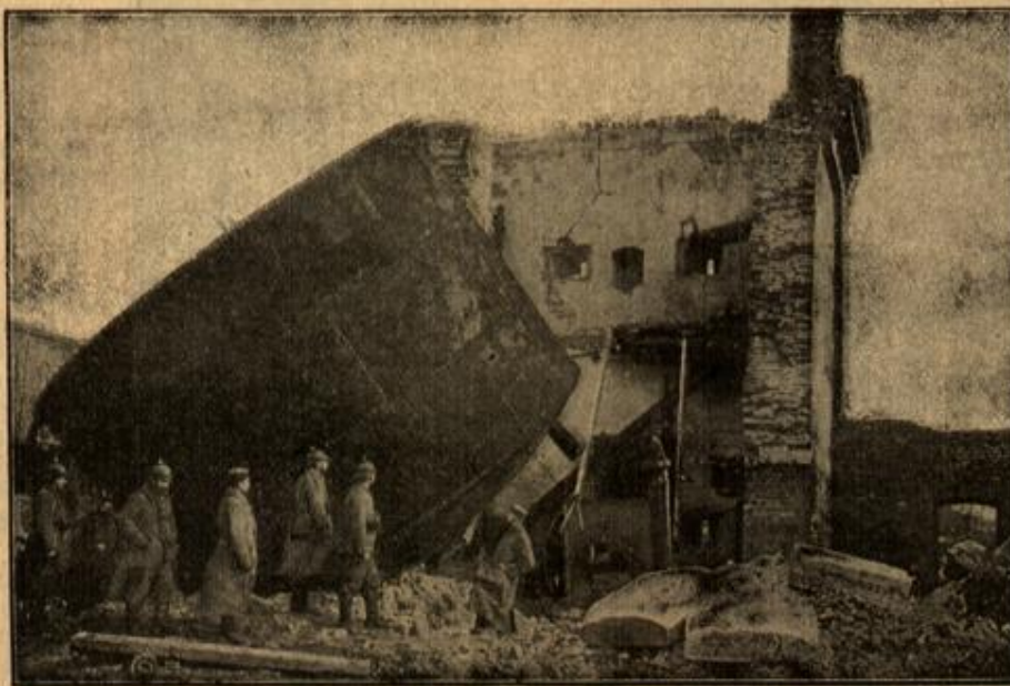
Gesprenkter Wasserturm in Nowo-Rado'msk.
