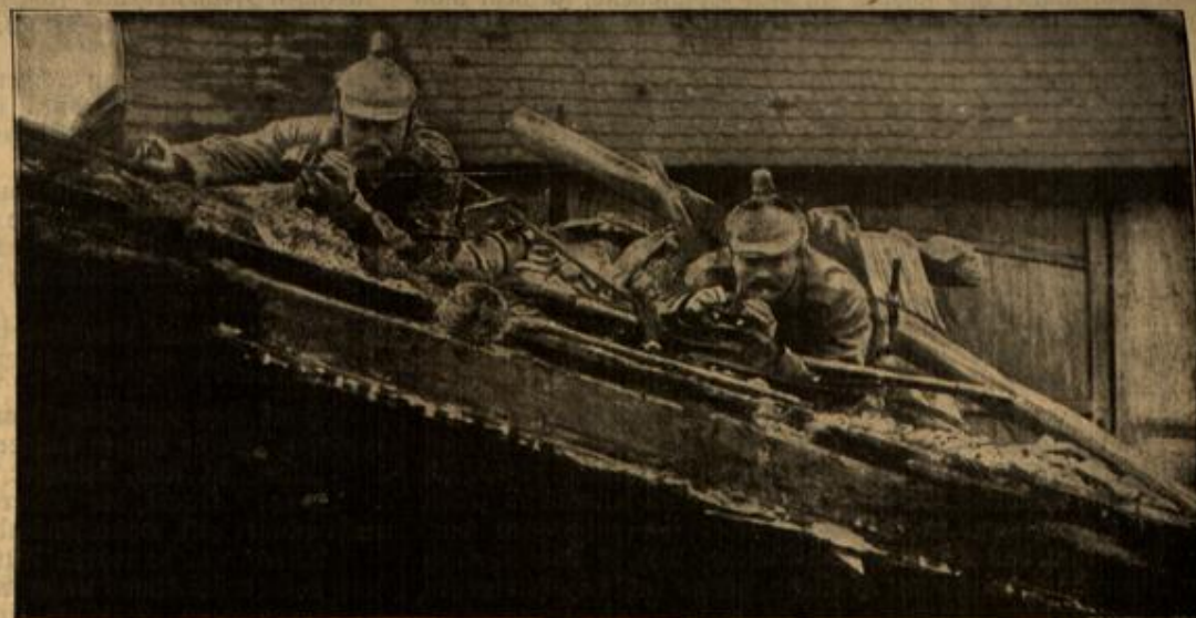
Eine Patrouille auf einem zerstörtem Dach.
