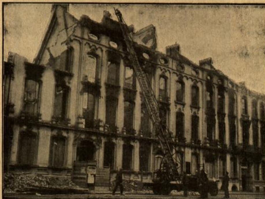
Aufräumarbeiten in Antwerpen.
