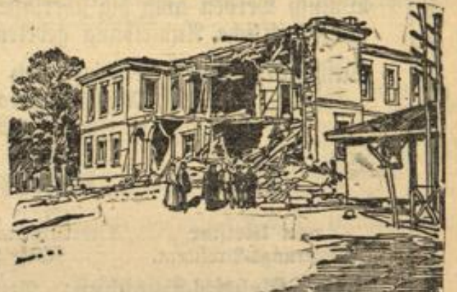
Die beschädigte u. z. z. unbewohnte frühere Kommandantur von Tschanak Kaleh.
