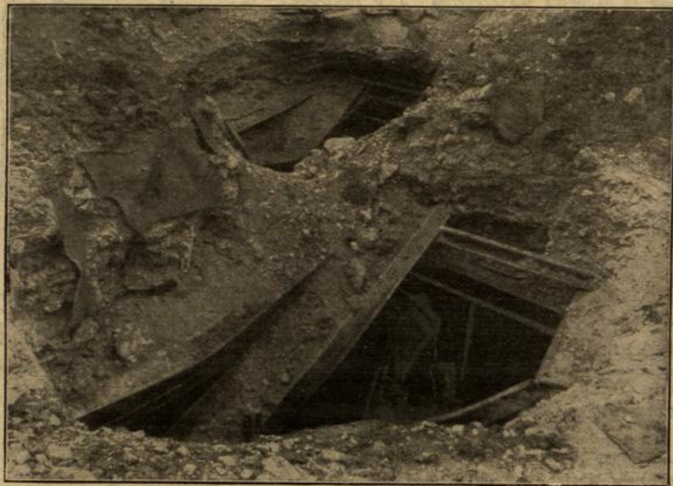
Geschosswirkungen an einem Forts in Rowno.
