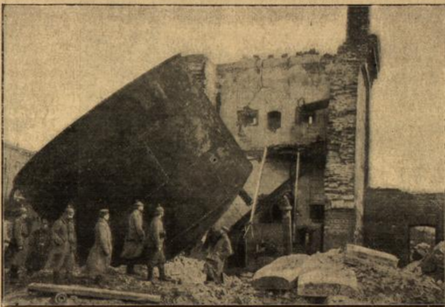
Gesprengrter Wasserturm in Nowo-Radomsk.
