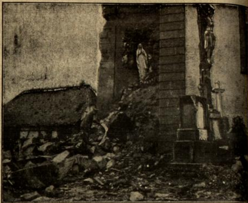
Blick in die zerstörte Kirche von Oberburnhaupt.
