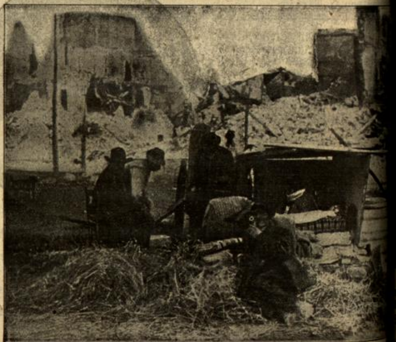
Aus dem italienischen Erdbebengebiet: Obdachlose Bewohner haben sich gegen die Kälte gebaut.
