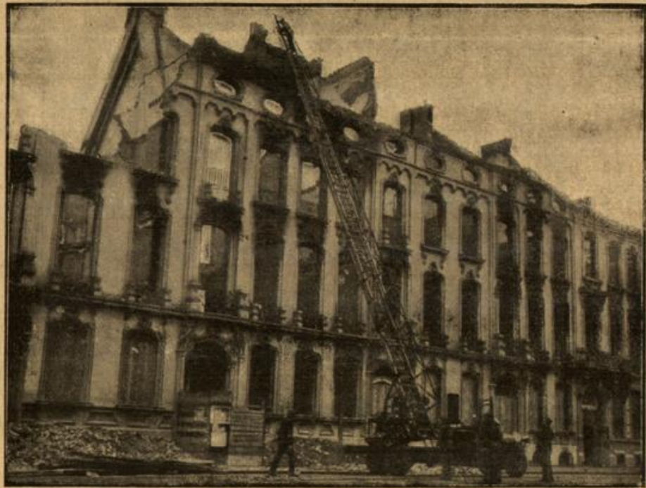
Austräumungsarbeiten in Antwerpen.
