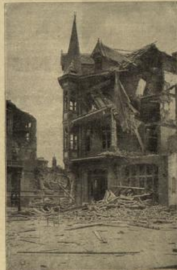
Durch englische Schiffgeschütze zerstörte Häuser in Widdershede (S. 77).
