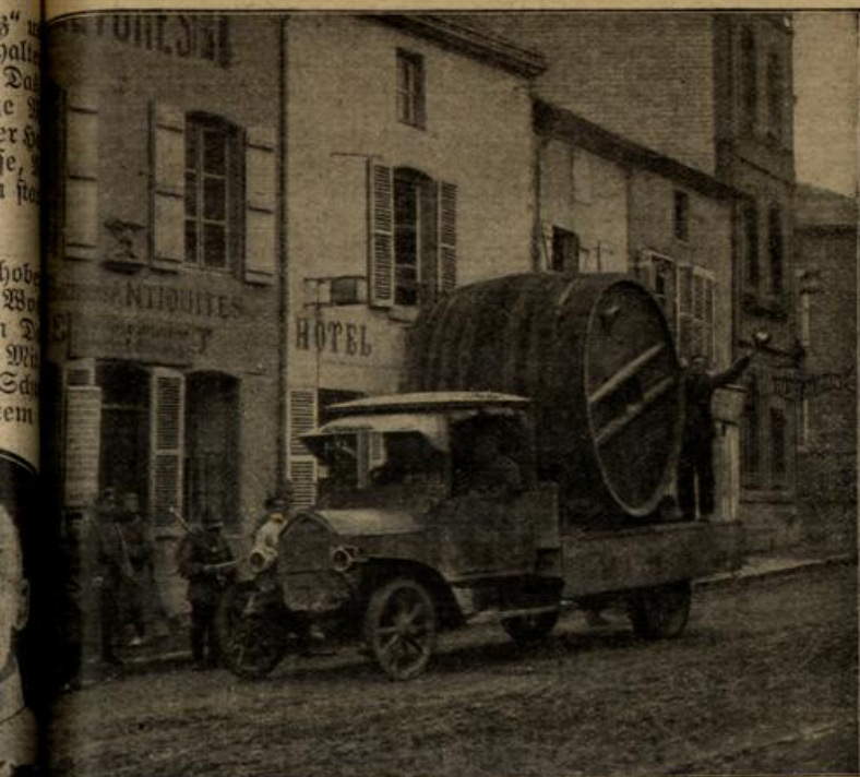
Sanitäre Maßnahmen im Westen.
