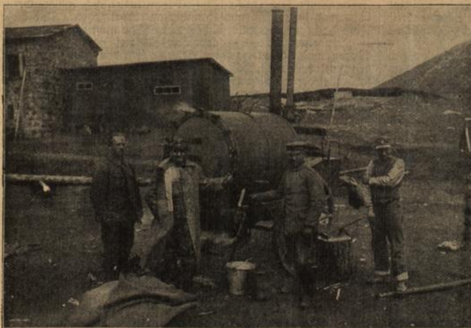
Körperfürsorge im Hochgebirgskrieg: Eine fahrbare Entlausungsanlage.
