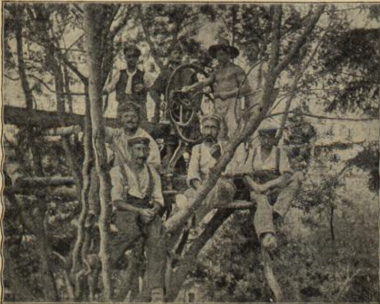
Pumpvorrichtung zum Entwässern und Trockenhalten von Schützengraben.
