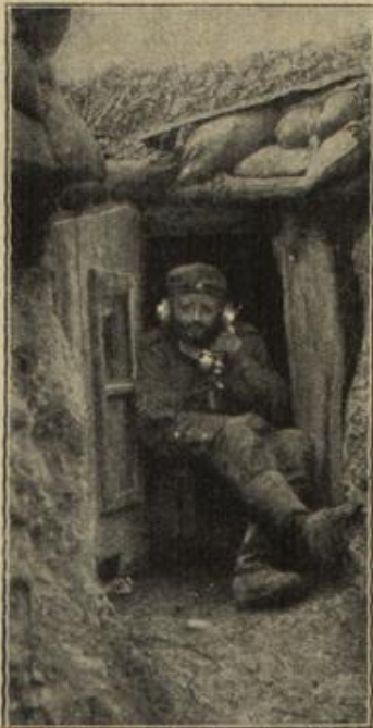
Telephonzelle im bombensicheren Unterstand.
