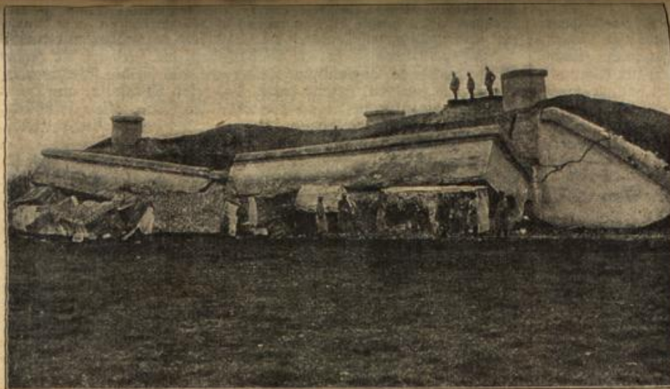
Nach der Einnahme von Liban: Befestigungswerke, die von den Russen vor der Übergabe der Stadt gesprengt wurden.
