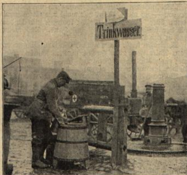
Zur Trinkwasserversorgung der deutschen Truppen in Russisch-Polen.
