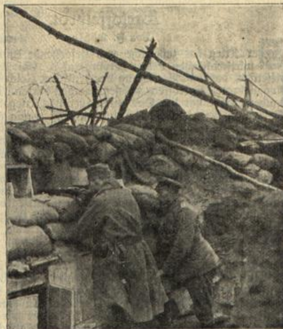
Sicherung der Schützengräben durch Drahtnetz vor Handgranaten.
