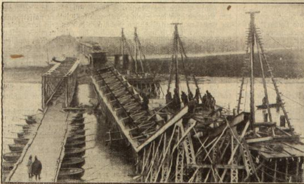
Die gesprengte Eisenbahnbrücke der Linie Kalisch—Warschau.
