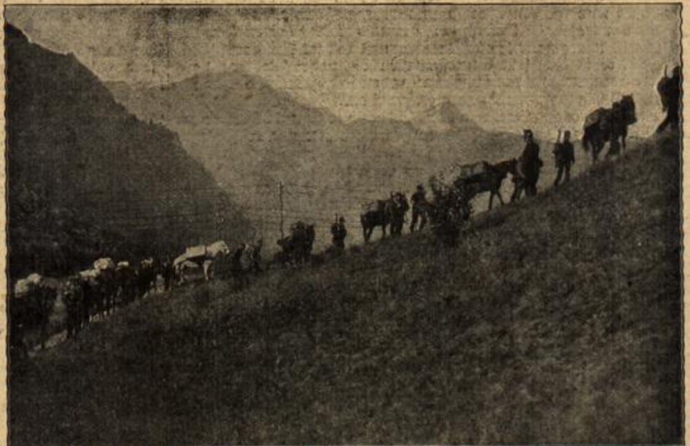
Schweizerische Bundesstruppen: Munitionszufuhr für die Befestigungsanlagen an der italienischen Grenze.
