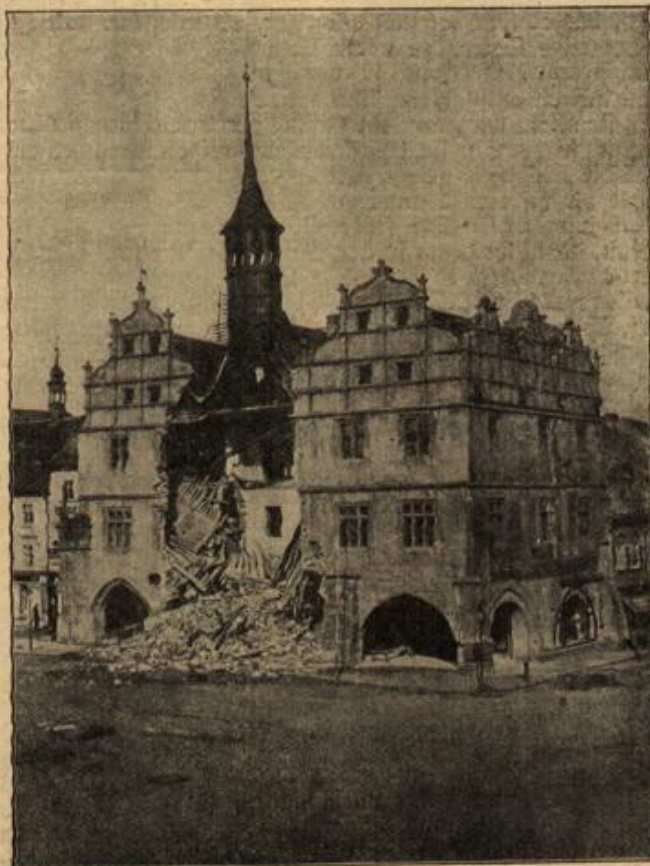
Der Einsturz des Leimertor Rathauses. (Mit Text.)
