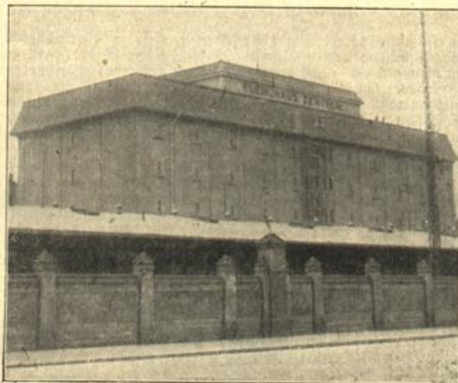
(Phot.: Leipziger Presse-Büro.) Blick auf das Kühlhaus.
