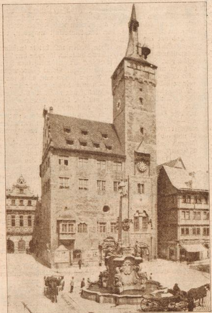
Renovierung des Grafen-Eckard-Turm in Würzburg. (Mit Text.)
