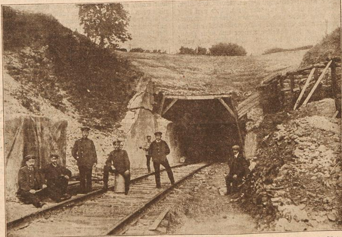
Ein belgischer Eisenbahntunnel, der von den Belgiern zur Behinderung der deutschen Bahntransporte zerstört und von den Deutschen binnen kurzer Zeit wiederhergestellt wurde.
