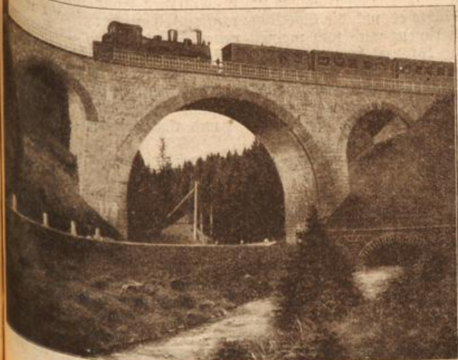
Ein Viadukt der neuen Oberharzbahn. (Mit Text.)
