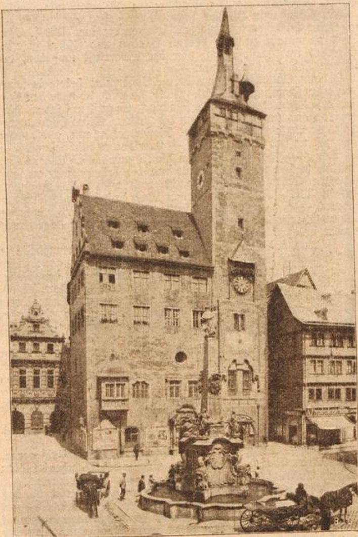
Renovierung des Grafen-Eckard-Turm in Würzburg. (Mit Text.)
