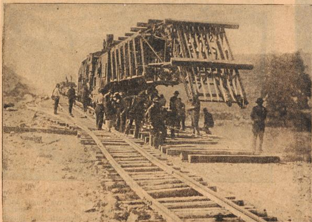
Eine schienenlegende Lokomotive. (S. 3.)
