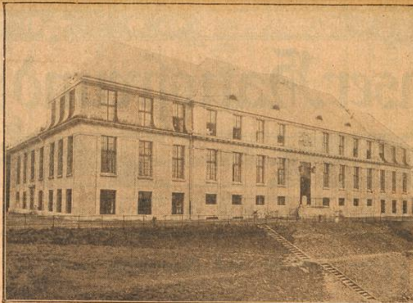
Das neue Rheinschiffahrts-Verwaltungsgebäude in Mannheim. (S. 8.)
