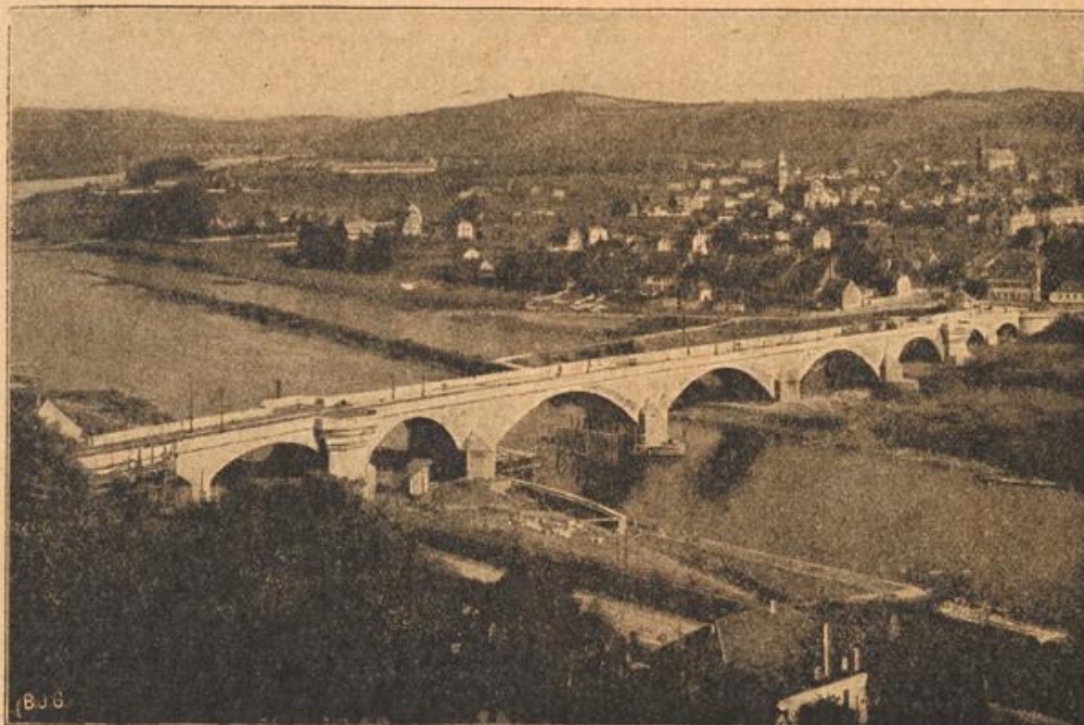
Die neue Kaiser Wilhelm-Brücke in Crier.
