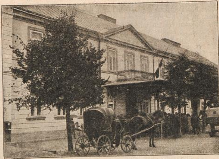
Das deutsche Gouvernementsgebäude in Suwalki. (Mit Text.)
