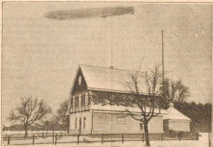
Die neue Telefunkenstation des Luftschiffbau Zeppelin in Friedrichshafen.
