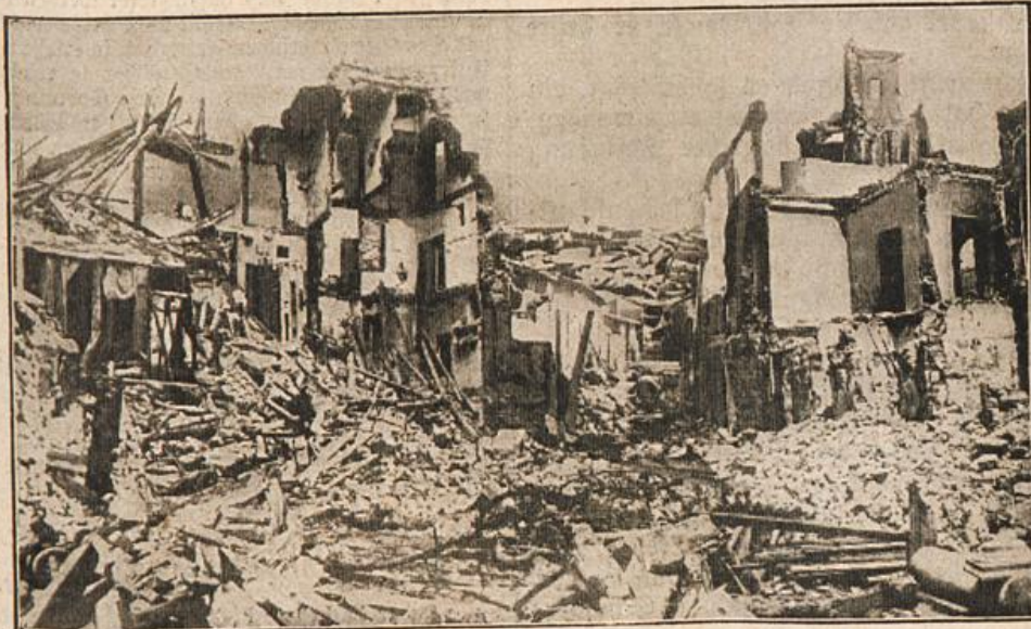
Von der Erdbebenkatastrophe in Italien: Blick auf ein vollständig zerstörtes Häuser- bzw. Straßenviertel von Sinera.
