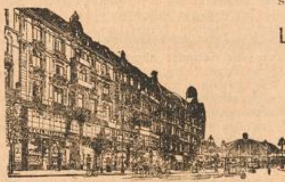
Neues Geschäftshaus der Firma Carl Klippel.
